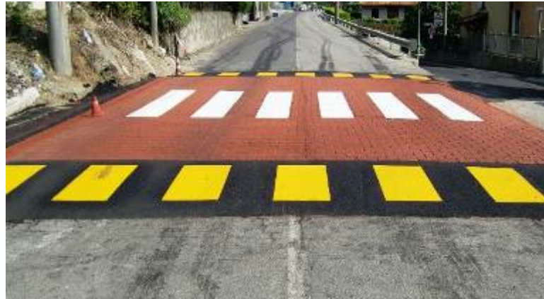
Figura 55: Attraversamento pedonale rialzato
