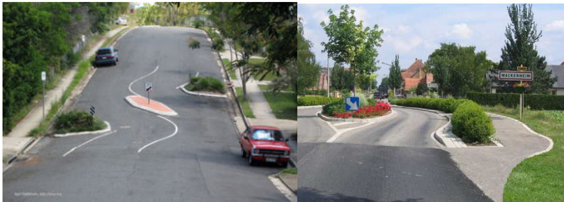
Figura 59: Esempi di disassamento stradale
